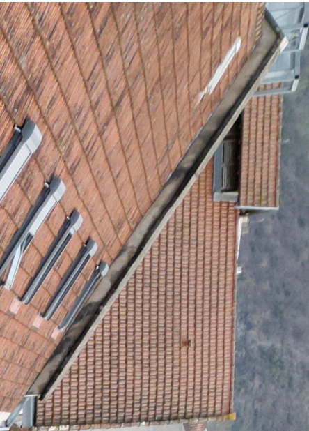
Rive: relevé béton
